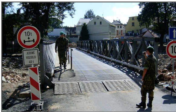
Фото 4. Грузоподъемность моста 40 тон и запрещено въезду машин с нагрузкой больше 10 тон/ось
