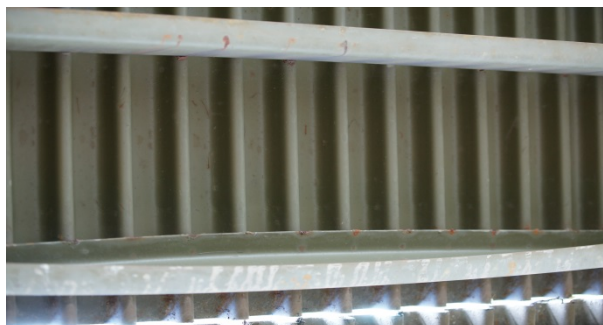
Фото 8в. Потеря устойчивости продольной бальки
