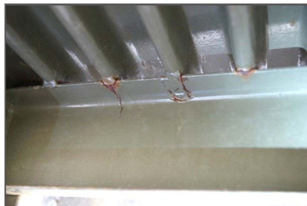
Фото 6. Развитие трещины до продольной
