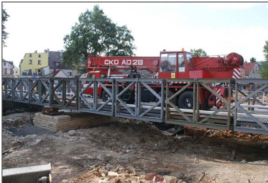
Фото 3. Испытание моста - нагрузка кран типа AD 28
