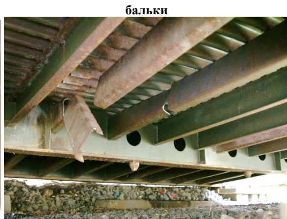
Фото. 7а, в. дальнейшее развитие трещины до перелома продольной бальки
