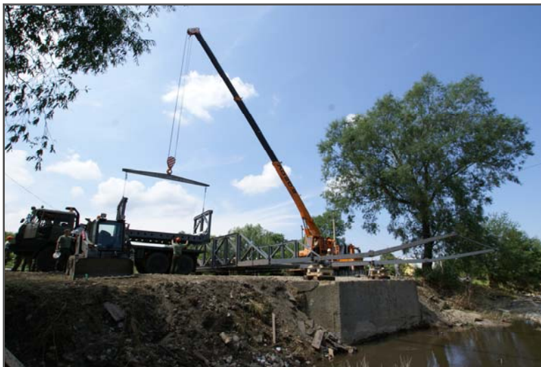
Фото 2. Строительство моста системы „MS”
