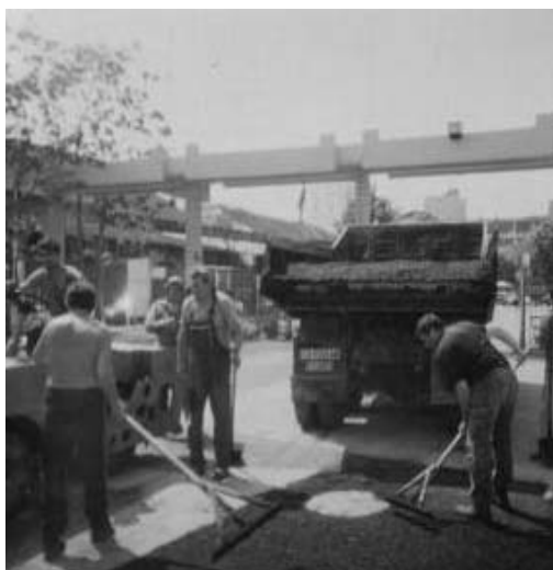
Фиг.5 Мястото на ремонта в МЕЛ София
