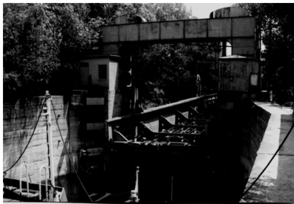
Фиг. 3 Повдигателни съоръжения на преходния мост на фериботното гнездо Русе.
